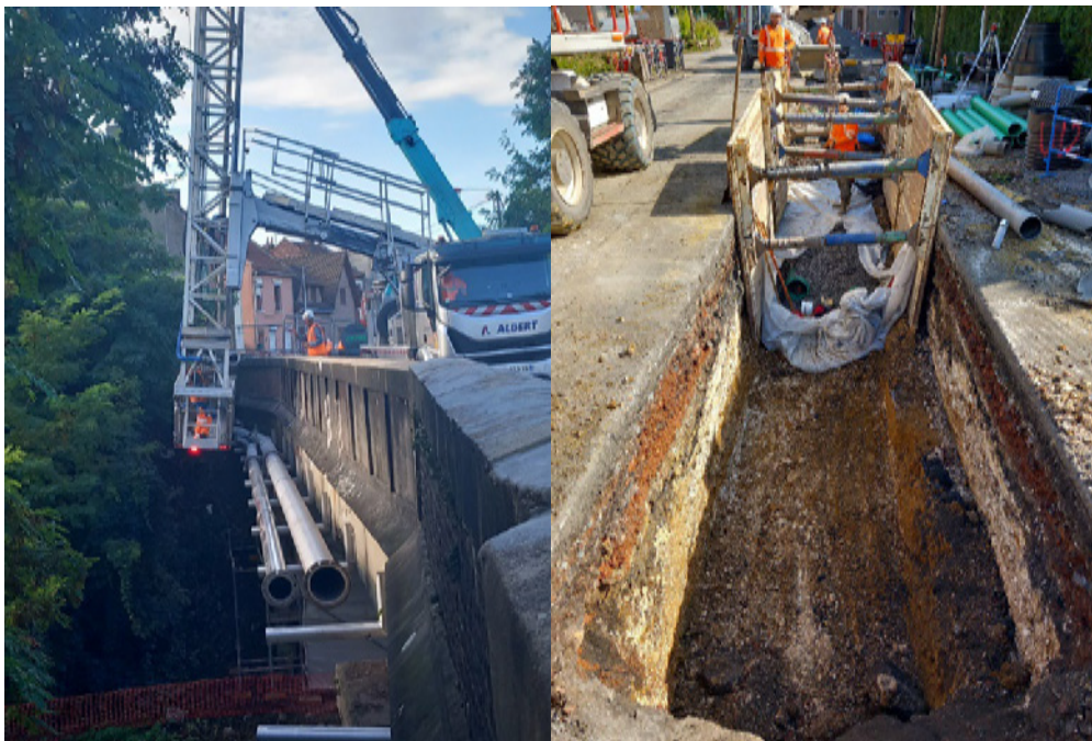
Pose des conduites d'assainissement sur ouvrage d'art - Pose des réseaux d'assainissement en tranchée ouverte
