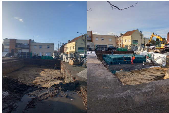
Réalisation d'un bassin d'infiltration d'un volume utile de 278 m 3 sur la place Mathieu
