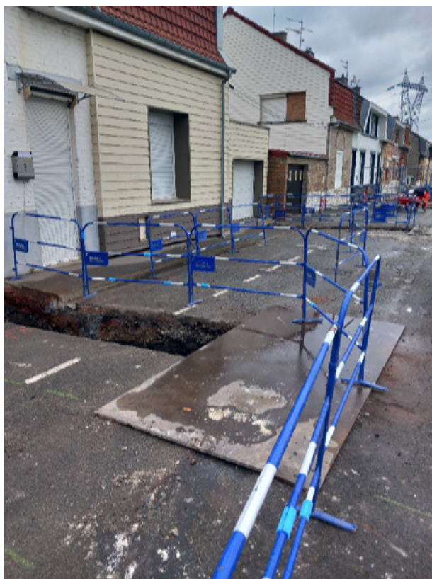
Réalisation des branchements sur collecteur principal
