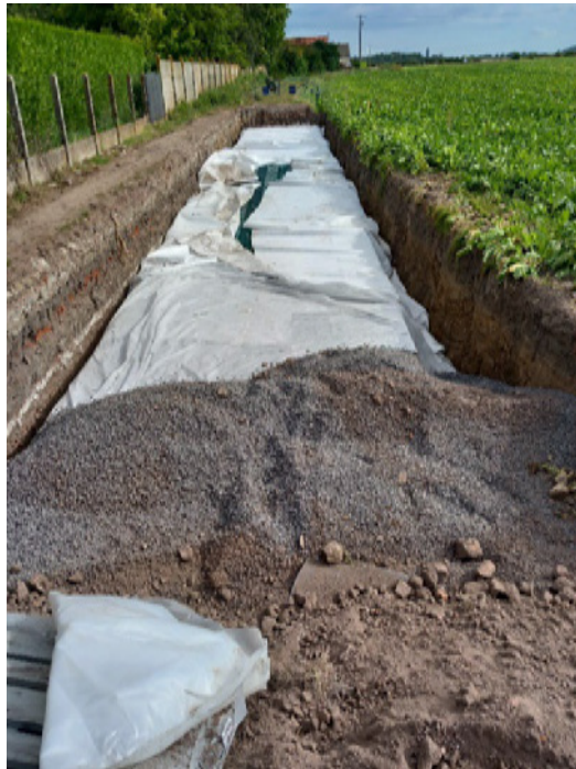
Réalisation du bassin d'infiltration de 106 m 3
