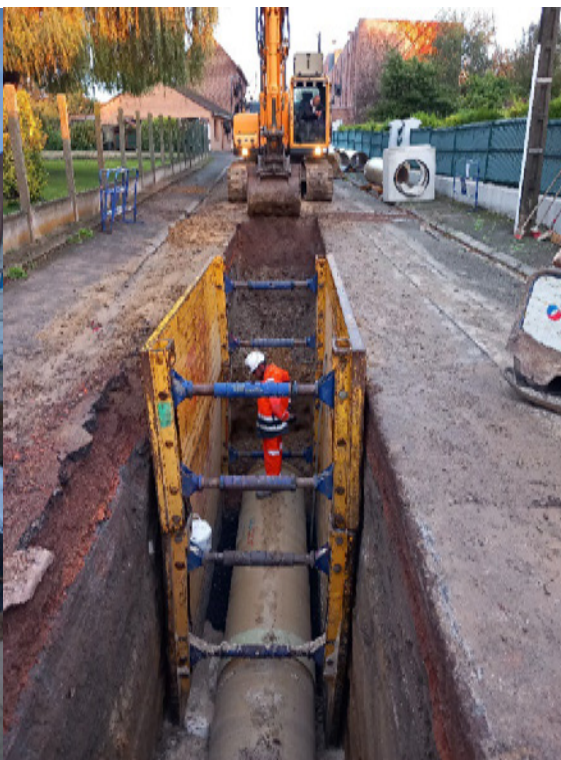
Pose du collecteur D800
