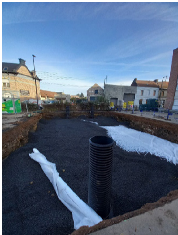
Réalisation du bassin d'infiltration
