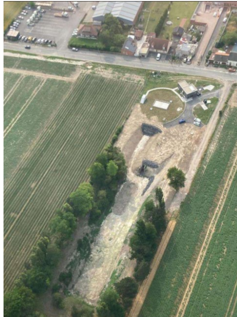
Vue aérienne des travaux des bassins
