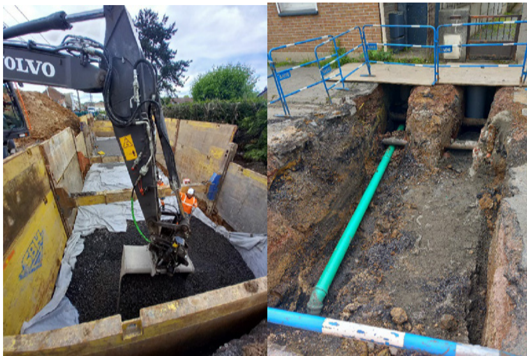
Réalisation du bassin d'infiltration Pose d'un branchement au collecteur principal
