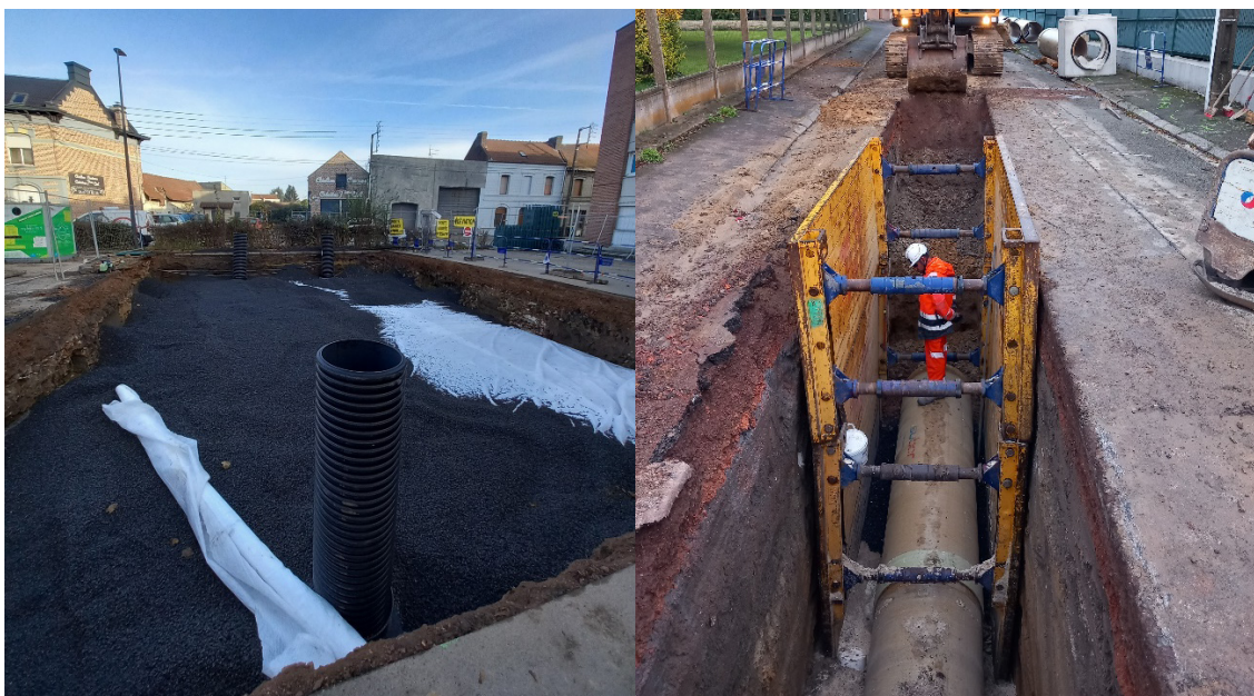
Réalisation du bassin d'infiltration
