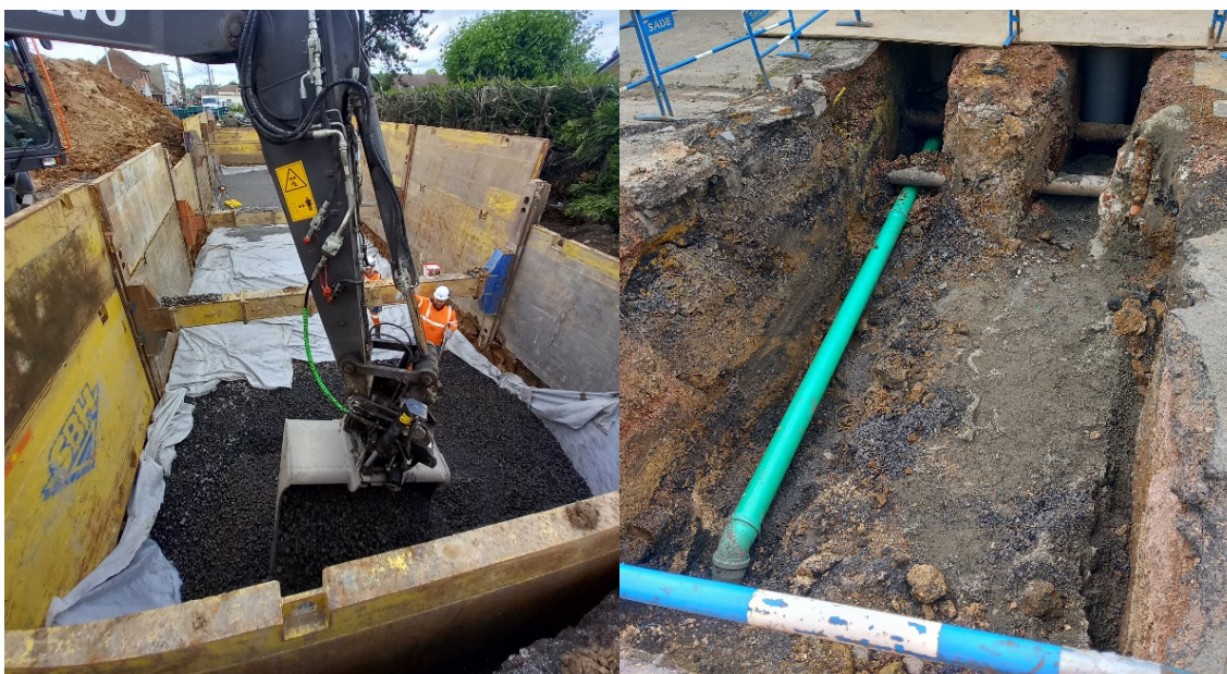
Réalisation du bassin d'infiltration
